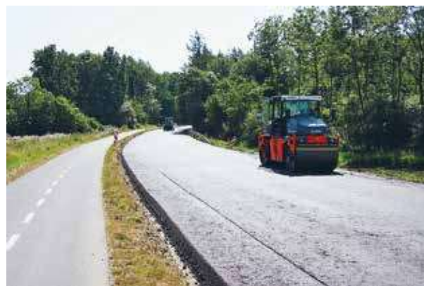
Komprimering af BSM-KMA. Foto: SR-Gruppen A/S.
