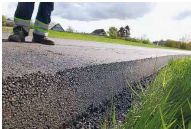
Nyudlagt BSM-KMA inden komprimering. Foto: Kim Brandt, Sjællandske Medier.
