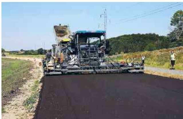
Udlægning af BSM-KMA i fuld bredde på 8,0 meter. Foto: Luccon A/S.
